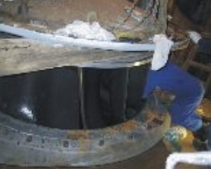
Покрытие лопаток турбин.
