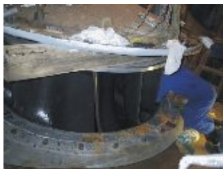
Покрытие корпусов насосов.
